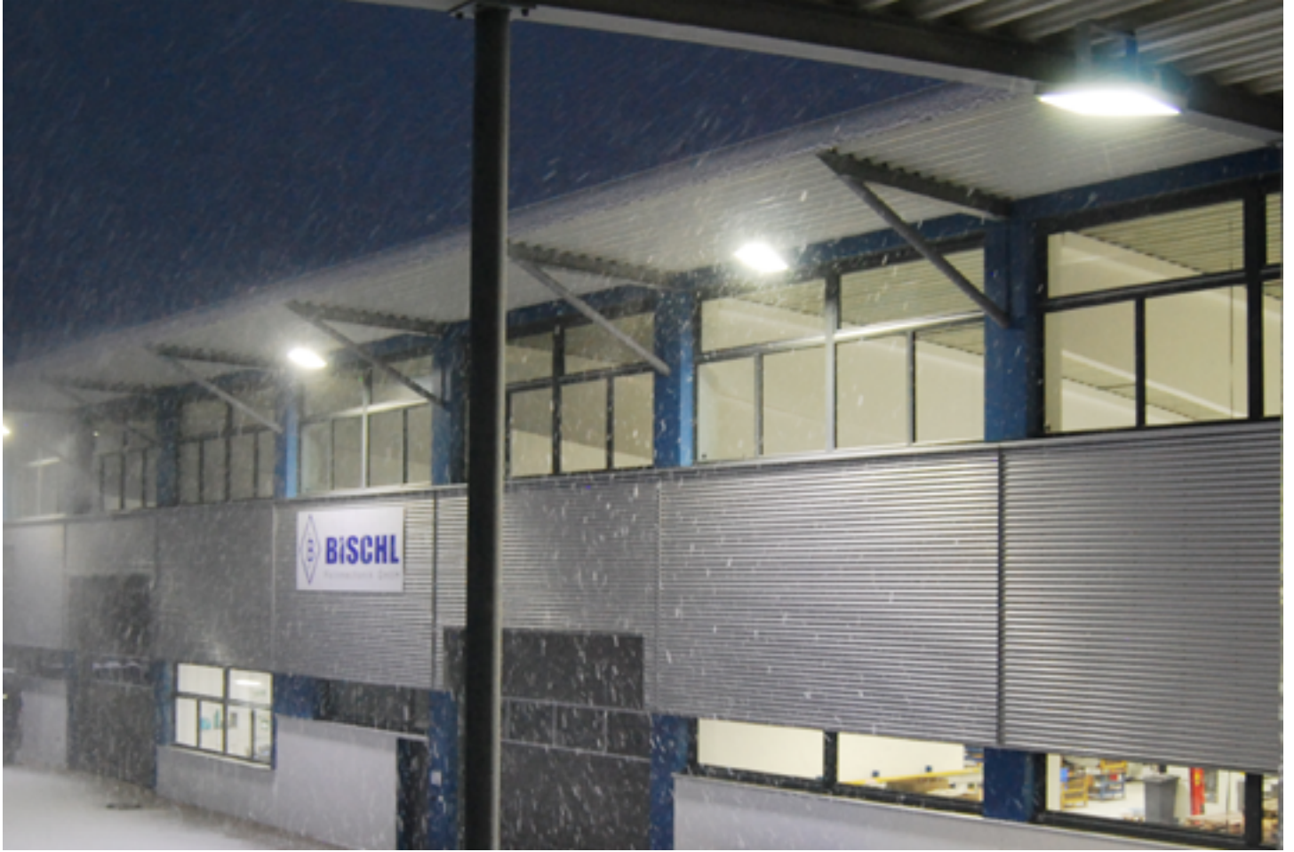
Außenbeleuchtung, die Wind und Wetter trotzt, am Hallenneubau eines feinmechanischen Betriebes
