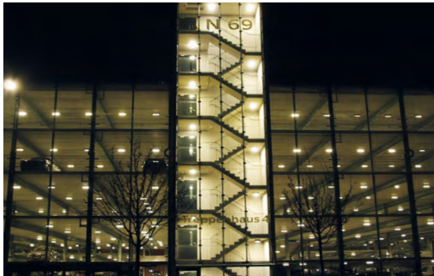
Langlebige und wartungsfreie Beleuchtung (seit 2012) im Parkhausneubau eines großen Autoherstellers
