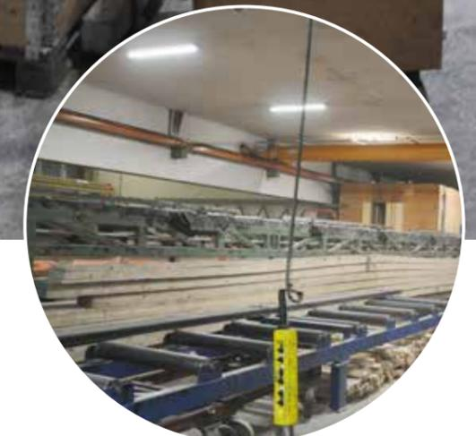
*HCL Hallenstrahler (Bild oben) und TGL Feuchtraumleuchten (runder Bildausschnitt) bei permanent hohem Staubaufkommen in der Holzverarbeitung*
